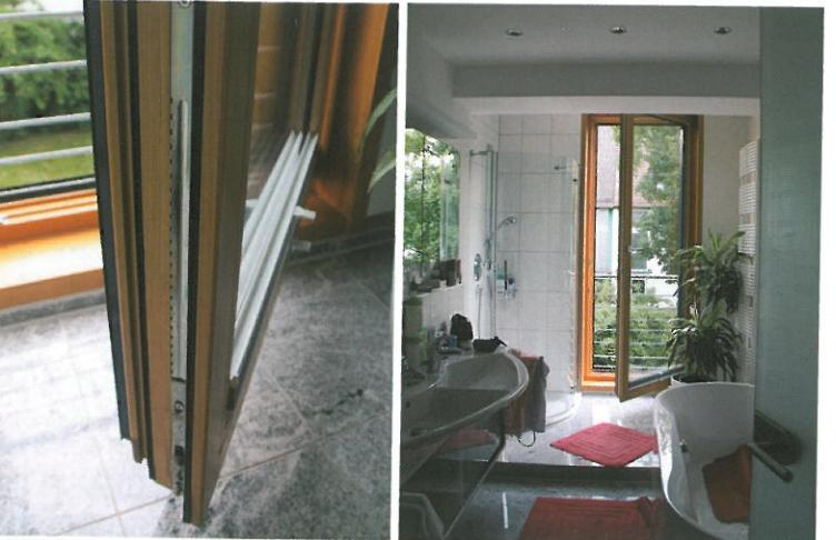
右／2階浴室。シャワー・ブース手前の桁の位置までがバルコニーだった。床暖房と壁取り付け温水循環ラジエーターを設置。屋内からは見えないが、窓の両サイドに25mm厚の真空断熱パネルとホウロウ引きガラスがはめこまれ、外観アクセントとなっている。左／3層ガラスに屋内側はカラマツ材、屋外側はアルミニウムの枠の窓は省エネルギー住宅のスタンダードになりつつある。金具も含めた枠の構造がものをいう。ドイツでは、ガラスが複層でも3層でも価格はそう変わらない。
